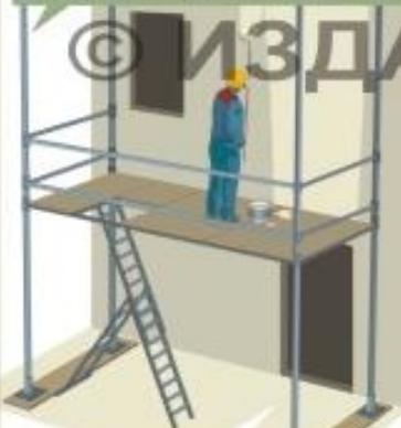
При штукатурных и малярных работах в местах, где имеются проходы или ведутся другие работы, применей настилы без зазоров.
