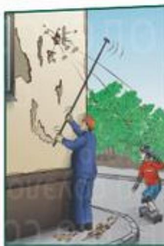
**П**ри обследовании состояния облицовки или штукатурки фасада здания простукиванием проход возле исследуемого строения должен быть закрыт временными ограждениями во избежание травмирования прохожих. Рекомендуется использовать также сигнальную ленту
