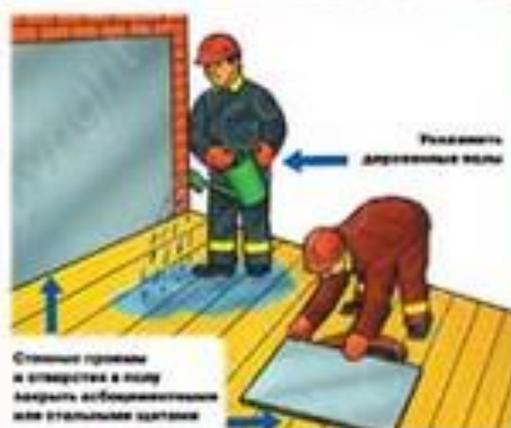
Стенные проемы и отверстия в полу закрыть огнеупорными или стальными щитами
