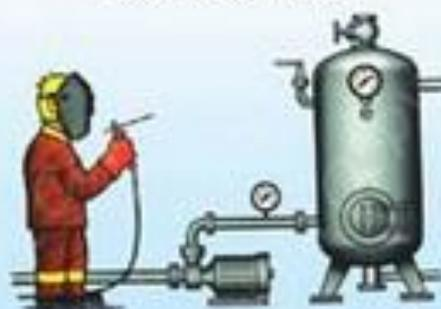
В ЗАМКНУТОМ ПОМЕЩЕНИИ одновременно вести газопламенные и электросварочные работы
